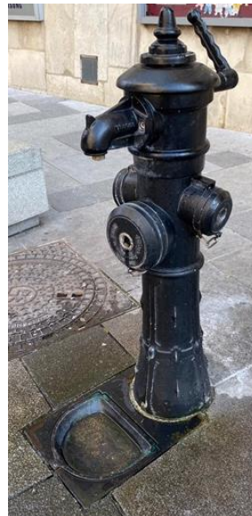
Altstadtrinkhydrant mit Ablaufbecken mit Schale
