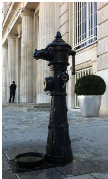
Altstadtrinkhydrant mit Ablaufbecken mit Gitter und darüber situierter Auffangschale
