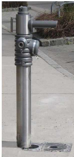
Edelstahltrinkhydrant mit Ablaufbecken mit Gitter
