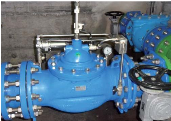
E2114-02 Durchflussregelung mit elektrischer Stellungsrückmeldung
