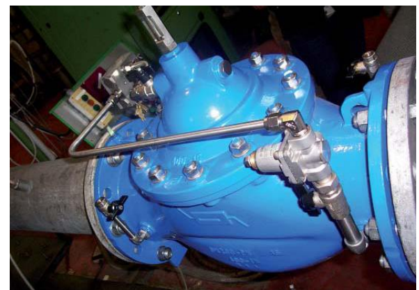
E2115-00 Druckreduzierung von 12 auf 1,4 bar bei schwankendem Durchfluss
