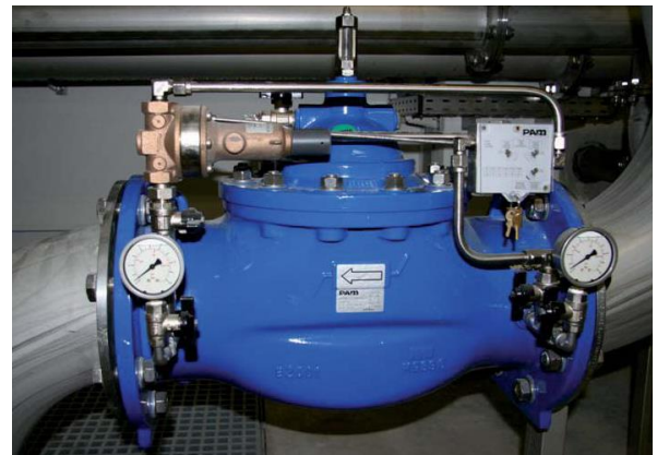
E2116-00 Sicherstellung eines konstanten Drucks im Anströmbereich der Armatur
