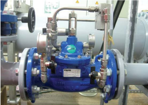
E2115-03 Erhaltung eines konstanten Ausgangsdrucks mit integrierter Rückflussverhinderung
