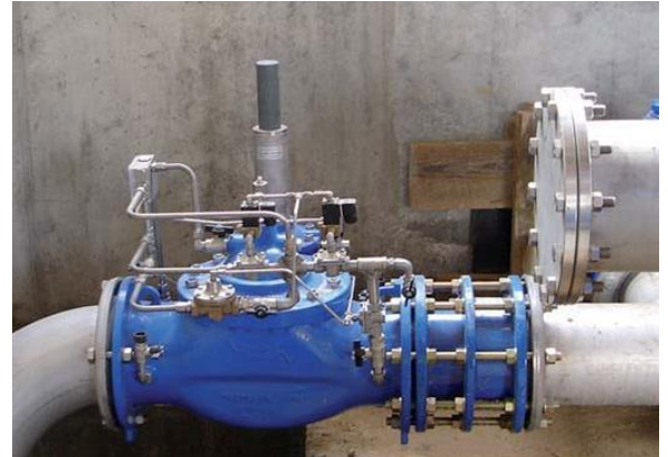
E2113-50 Durchflusskontrolle mit elektrischer Fernsteuerung
